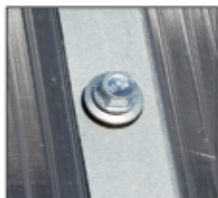
Усиленное крепление: саморез + оцинкованная лента
